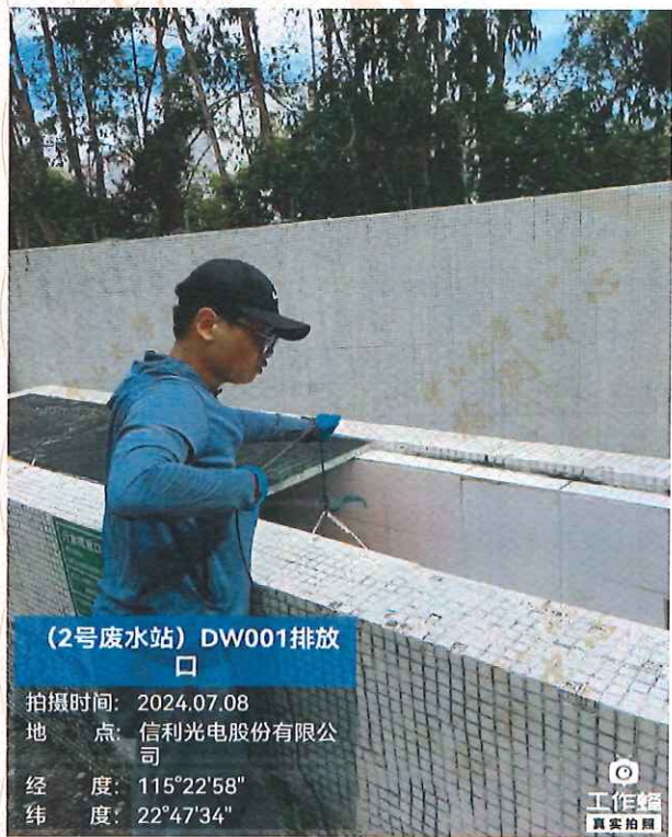
DW001（2号废水站）
