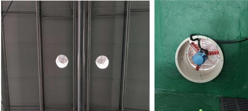
图 4 防爆型轴流风机设备一览
